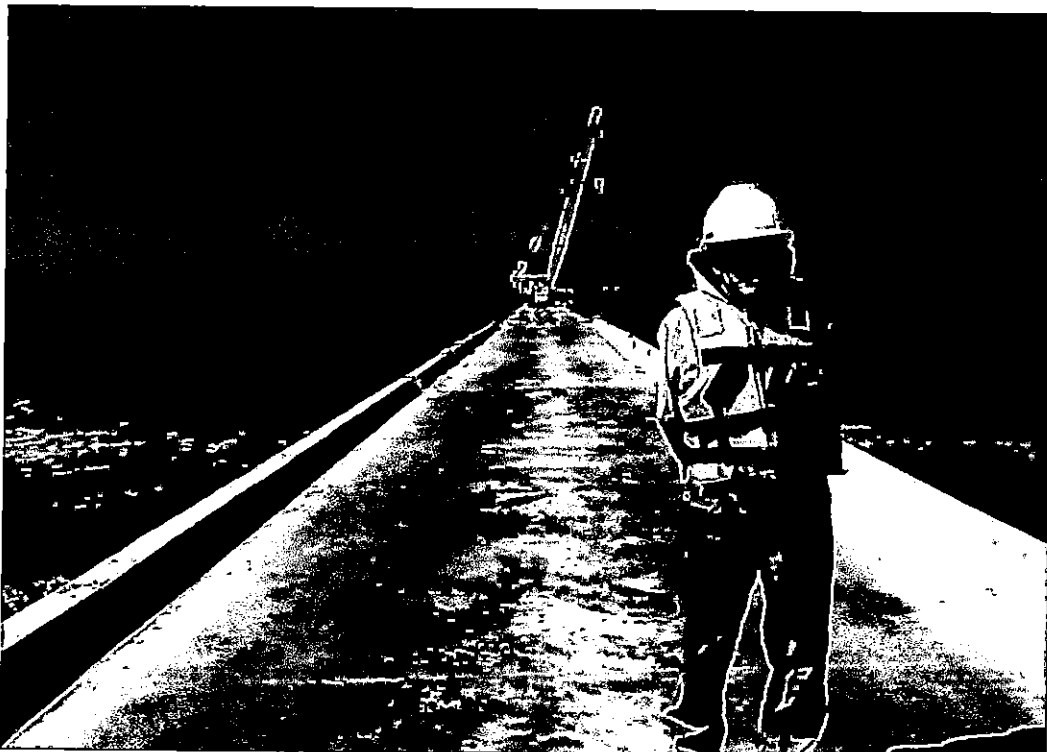
Otra vista de la Supervision a la altura del eje 125
